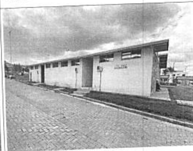
Fotografía N°6: Vista de locales comerciales.
