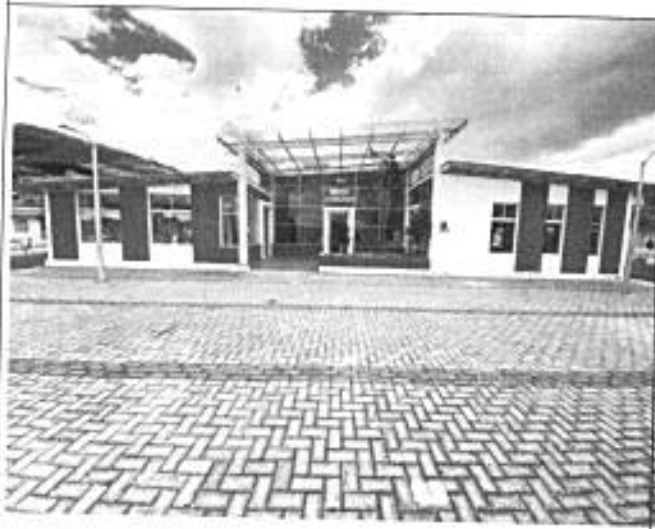
Fotografía N°4: Vista Exterior – Área comunal.
