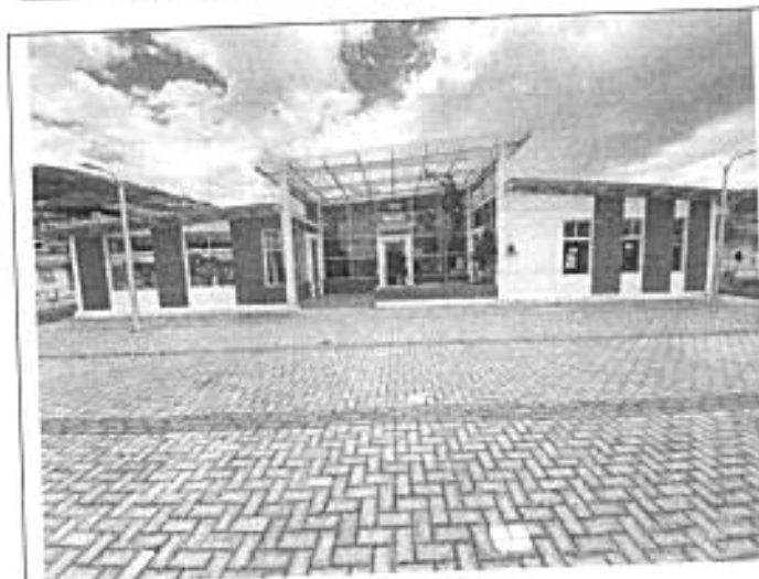
Fotografía N°4: Vista Exterior - Área comunal.
