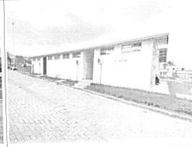
Fotografía N°6: Vista de locales comerciales.
