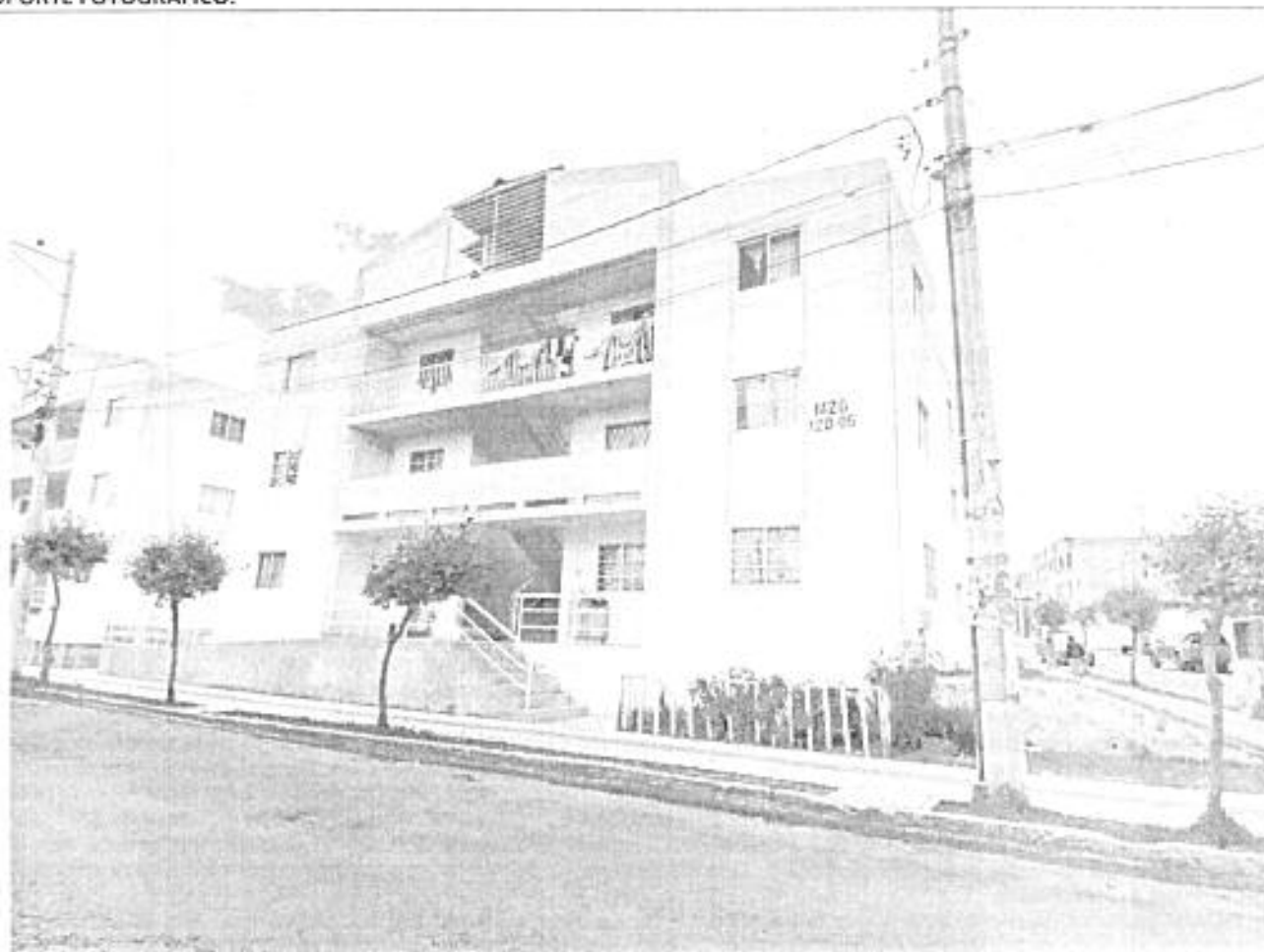
Fotografía Nº1: Vista Exterior – Bloque de 3 plantas con 12 unidades de vivienda por bloque.
