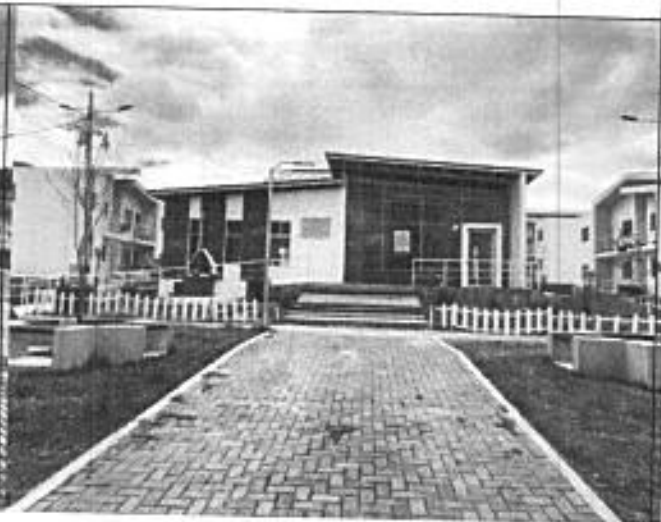
Fotografía N°5: Vista Exterior – Área comunal.
