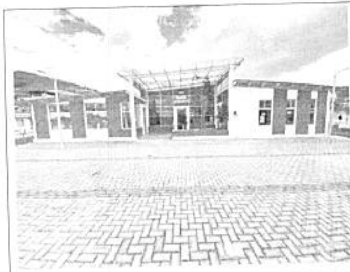
Fotografía N°4: Vista Exterior - Área comunal.
