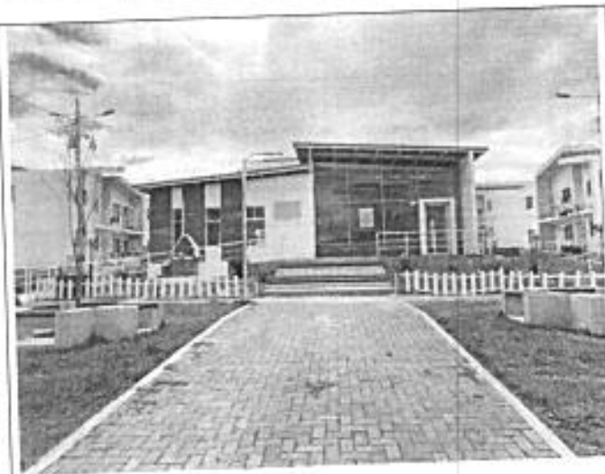
Fotografía N°5: Vista Exterior - Área comunal.
