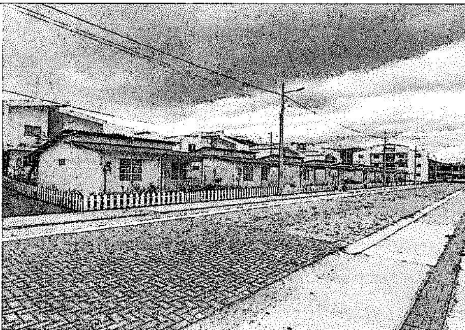
Fotografía N°3: Vista Exterior – Bloques de 1 planta.
