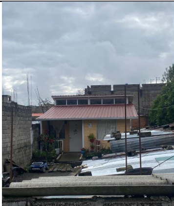
Imagen No. 1: Vista general de la Edificación, ingreso, predio No. 379487.
