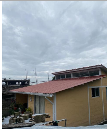
Imagen No. 2: Vista general en perspectiva de la Edificación, predio No. 379487.
