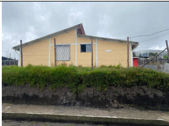
Imagen No. 3: Vista de la fachada lateral Norte.
