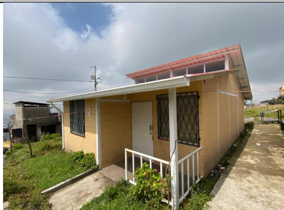
Imagen No. 1: Vista general de la Edificación, ingreso, predio No. 3672585.
