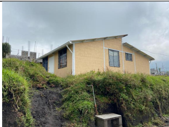
Imagen No. 2: Vista de la fachada lateral Oeste.
