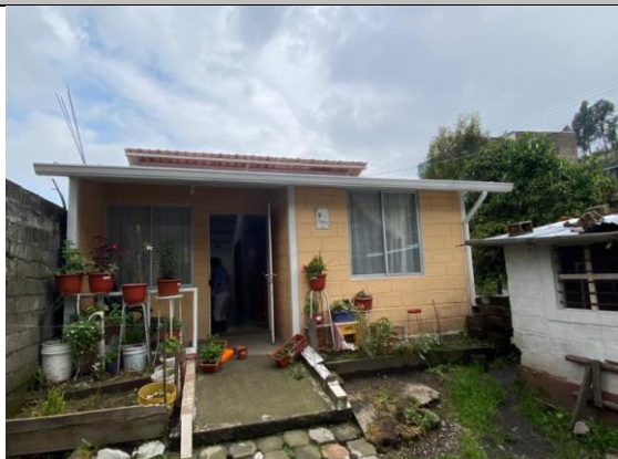
Imagen No. 1: Vista general de la Edificación, ingreso, predio No. 379487.
