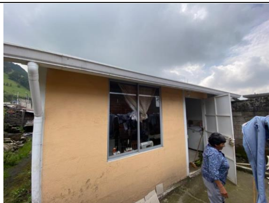
Imagen No. 6: Vista exterior del predio hacia la parte posterior de la edificación, hacia el Oeste.
