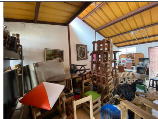
Imagen No. 6: Vista interior de Sala-Cocina.- No existen cambios ni alteraciones en su composición arquitectónica interna.
