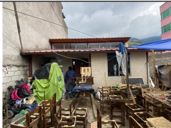
Imagen No. 2: Vista de la fachada frontal-Este.
