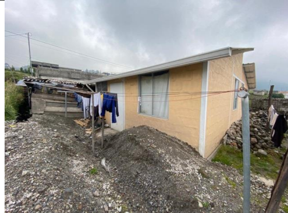
Imagen No. 2: Vista de fachada posterior. No se constata ningún proceso constructivo recién o en marcha.
