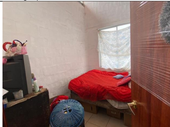
Imagen No. 6: Vista interior dormitorio. No se constata ningún proceso constructivo recién o en marcha.
