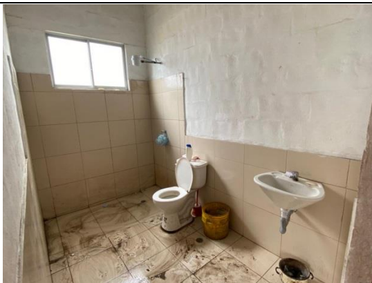
Imagen No. 5: Vista interior de baño. No se constata ningún proceso constructivo recién o en marcha.
