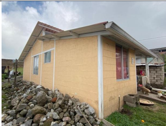
Imagen No. 3: Vista de fachada lateral. No se constata ningún proceso constructivo recién o en marcha.
