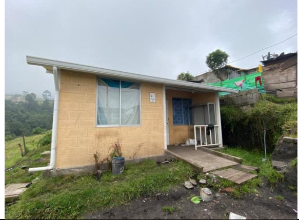
Imagen No. 2: Vista de fachada frontal. No se constata ningún proceso constructivo recién o en marcha.
