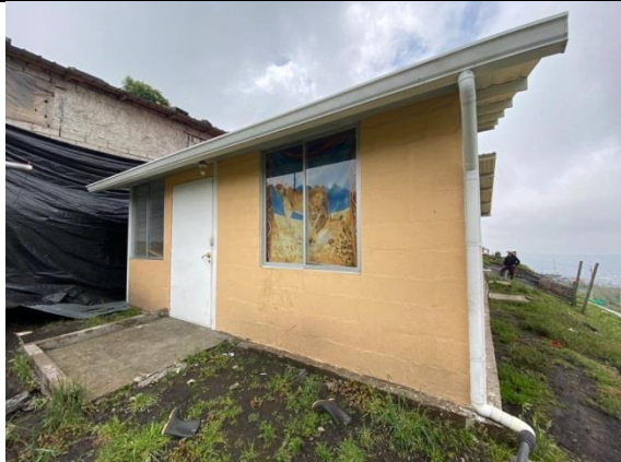
Imagen No. 3: Vista de fachada posterior. No se constata ningún proceso constructivo recién o en marcha.
