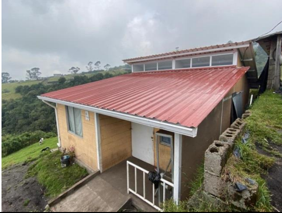
Imagen No. 1: Vista general del frente del predio No. 3618873.
