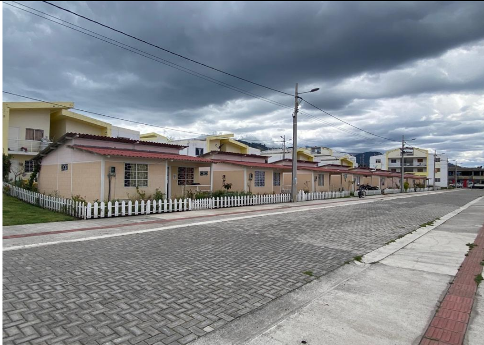
Fotografía N°3: Vista Exterior – Bloques de 1 planta.
